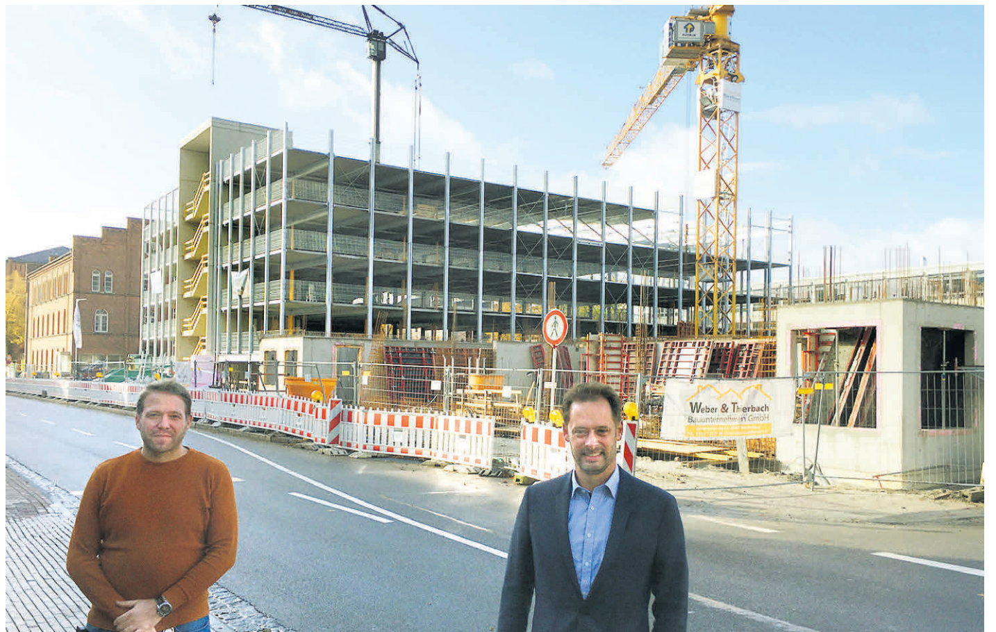
Vor dem rasant wachsenden Neubau: Tobias Willenborg, stellvertretender Leiter Bau und Immobilien (links), und Christian Gutendorf, Kaufmännischer Direktor und Geschäftsführer August Carrée (beide Evangelisches Krankenhaus) BILD: THOMAS HUSMANN
